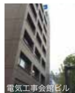
電気工事会館ビル
